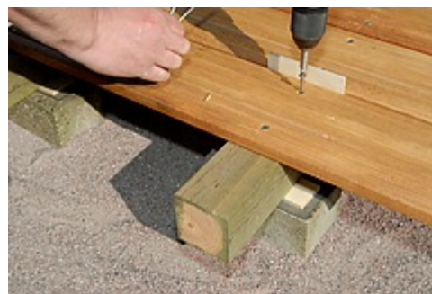
Afstand 3 mm mellem brædderne
