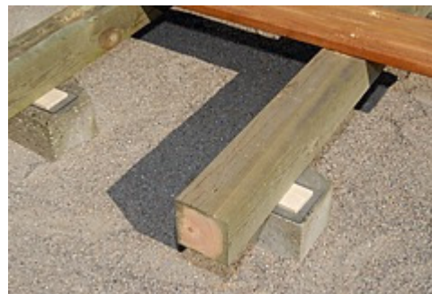
2 skruehuller forbores i anden top fra siden
